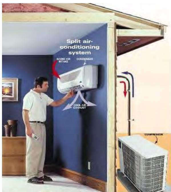
*Раздельно агрегатированное оборудование кондиционирования воздуха: настенный внутренний блок и наружный блок*
