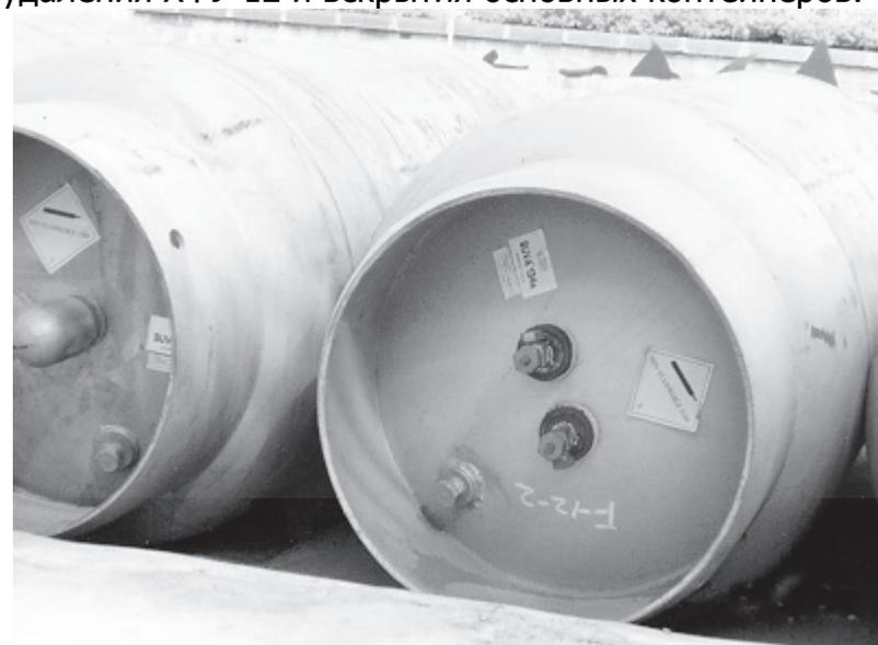
Фото 4. Впускные клапаны малых цилиндров, содержащих ГФУ-134а.
