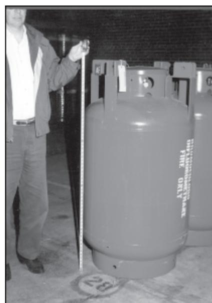
Фото19 – Цилиндр с галоном 1211 (бромхлордифторметан)
