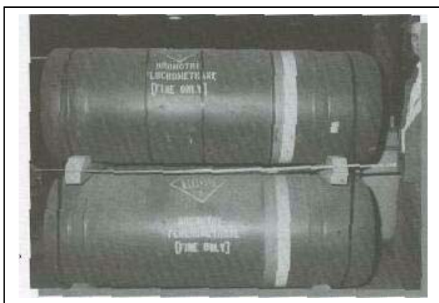
Фото 26: Баки галонов 1301 (бромтрифторметан)
